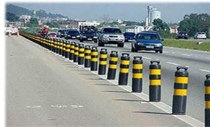
Como se pode ver, há na figura vários dispositivos dispostos ao longo da via, chamados de cilindros delimitadores. Segundo estabelece o Anexo II do CTB, atualizado pela Resolução CONTRAN nº 160/04, esses cilindros pertencem a uma espécie de dispositivo auxiliar cuja finalidade é a de melhorar a percepção do condutor quanto aos obstáculos e situações geradoras de perigo potencial à sua
